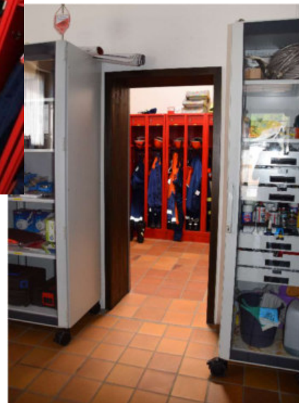
Die Tür zur Umkleidekabine ist nicht feuerhemmend (T 30) ausgeführt!
