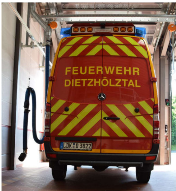
Der Anschluss der Absauganlage befindet sich links neben dem Fahrzeug.
