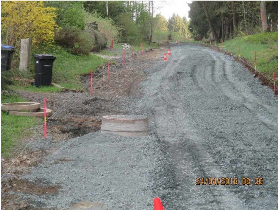
Revisionsschächte des Kanals und Hydrantenkappen der Wasserleitung werden ebenso angepasst wie die betroffenen Grundstückszufahrten.
