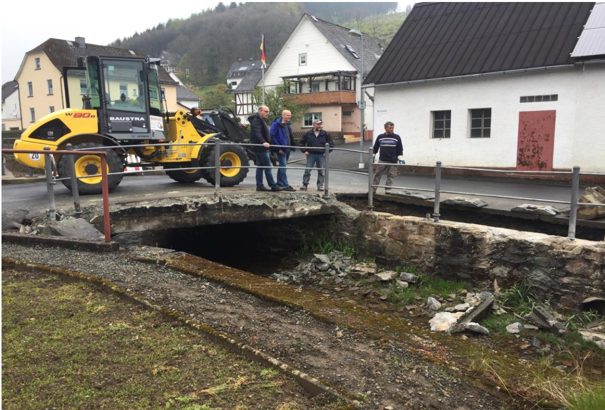
Begutachten die Fortschritte (von links): Bauhofleiter Matthias Reuschel, Bürgermeister Andreas Thomas sowie Angestellte der Baufirma
