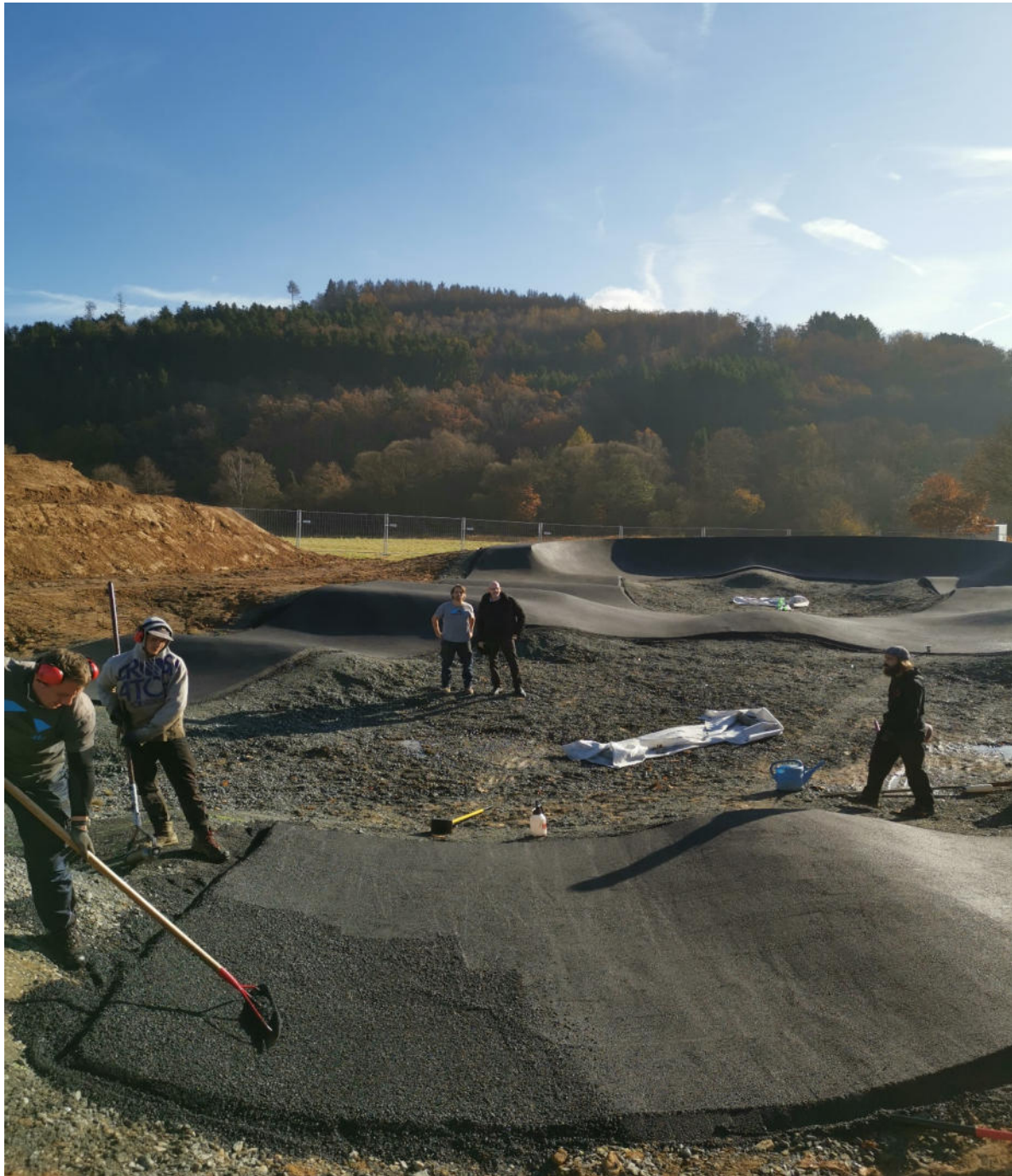
Bildmitte: Bauleiter Christian Haas (Pumptrack.de) und Bürgermeister Andreas Thomas machen sich ein Bild von den laufenden Asphaltarbeiten
