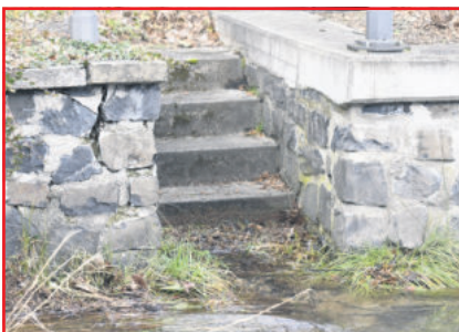
Die rechte Mauer ist schon saniert, links sind Schäden deutlich sichtbar.
