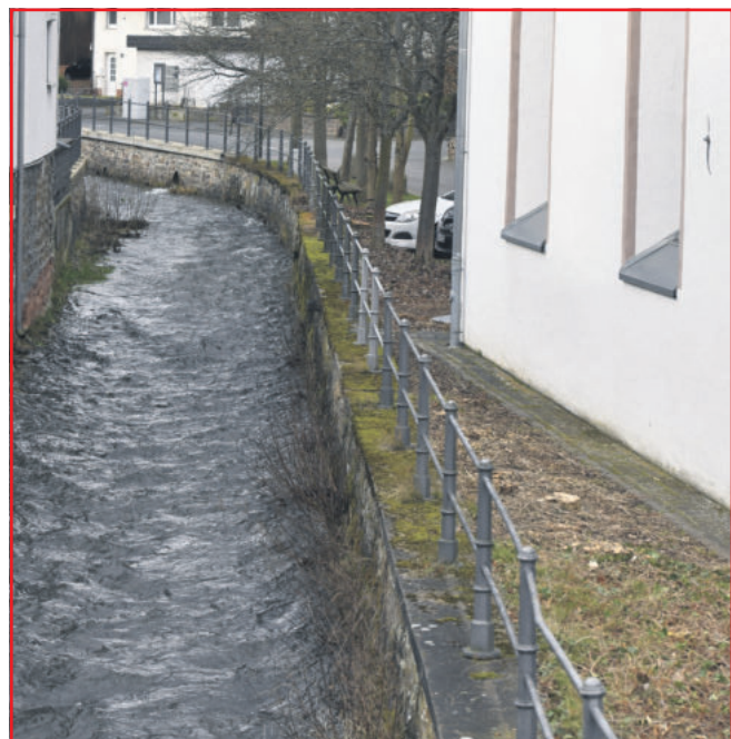
Die Ufermauer der Dietzhölze im Bereich der Rittershäuser Kirche wird ab Mitte Mai saniert.
