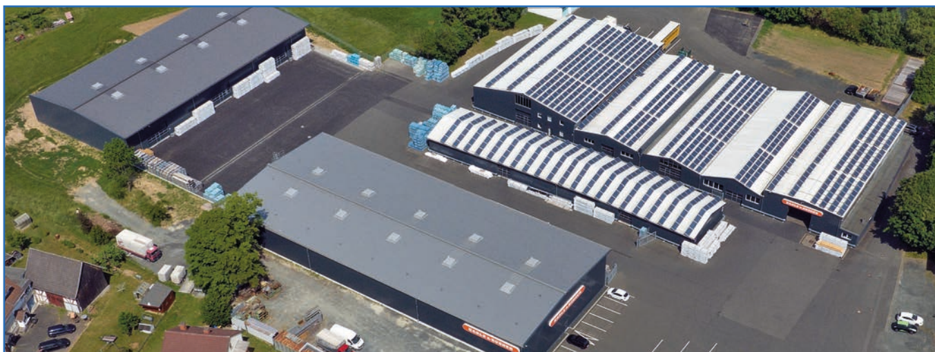
Die Vogelperspektive gibt einen guten Überblick des Werksgeländes von Karle & Rubner in Mandeln.
