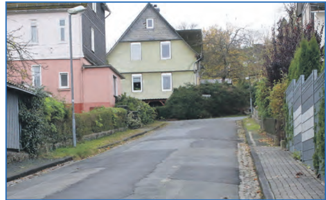
Die Jägerstraße in Ewersbach soll im nächsten Jahr für 714.000 € grundhaft erneuert werden.
