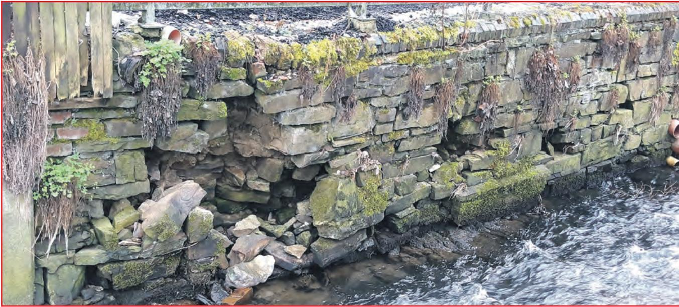
*Verschiedene Hochwasser hatten der alten Bruchsteinmauer an der Dietzhölze stark zugesetzt, sodass sie ersetzt werden musste.*
