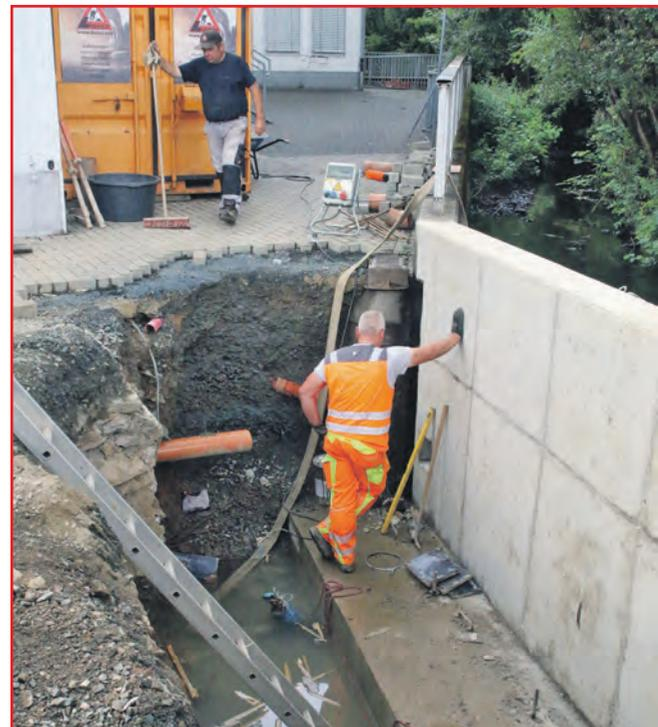
*Deutlich über mannshoch ist die neue Stützmauer für den Parkplatz hinter den Schulcontainern in Ewersbach. Hinter der Mauer klapft hier noch die große Baugrube, die für die Errichtung nötig war.*
