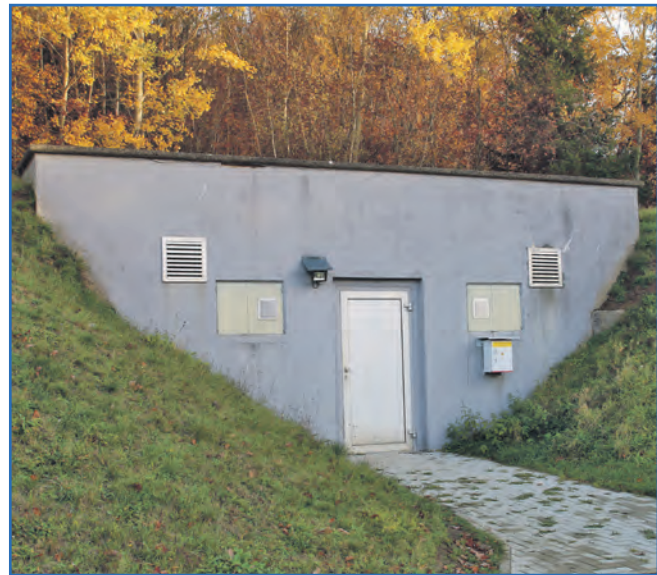
Zwei Wasserkammern des Hochbehälters Forst müssen im kommenden Jahr instandgesetzt werden.
