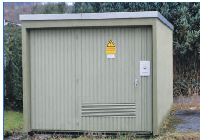
*Neben der Kirche in Mandeln steht eine von drei Trafostationen, die den Strom der Überlandleitungen auf Niederspannung reduzieren und an die fast 500 Haushalte im Dorf verteilen.*
