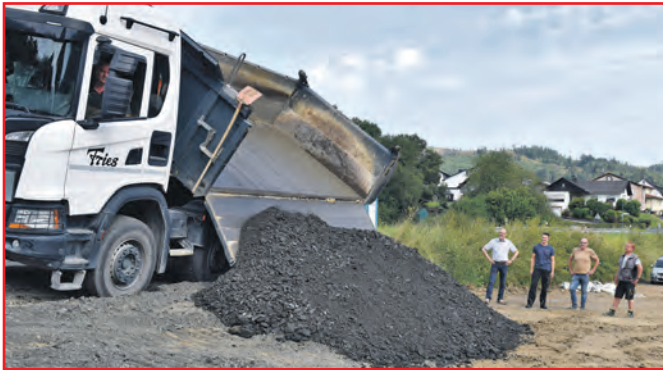
Am 1. August 2024 wird die Baustelle offiziell eingerichtet.
