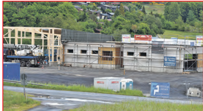
Ende Mai 2025 konnte das Richtfest gefeiert werden.
