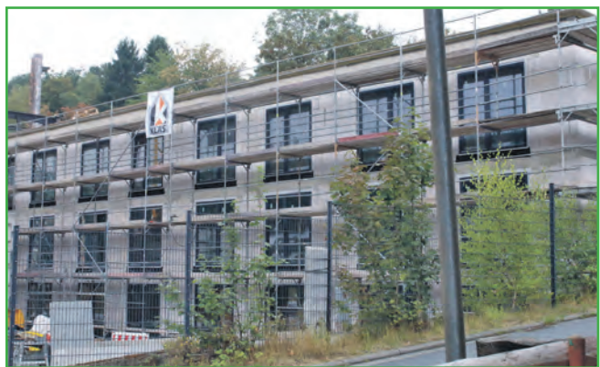
Auf dem Gelände des Nationalen Automuseums ist der Neubau eines Hotels schon weit fortgeschritten.
