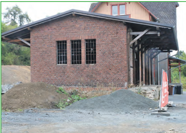
Neben der Lagerhalle des ehemaligen Ewersbacher Bahnhofs, wo jetzt noch Erd- und Schotterhaufen liegen, soll das neue Rathaus gebaut werden.
